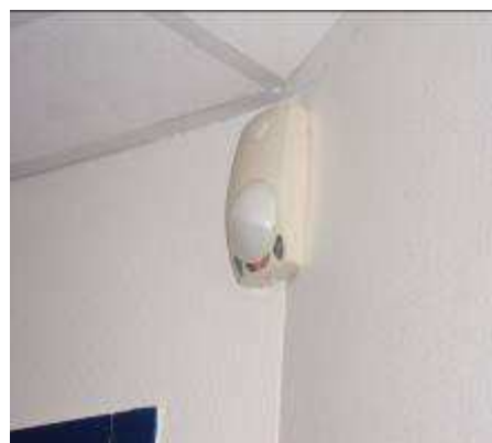
Alarme volumétrique anti-intrusion et de clavier d'armement et désarmement anti- intrusion
