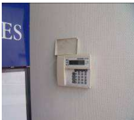
Alarme volumétrique anti-intrusion et de clavier d'armement et désarmement anti- intrusion
