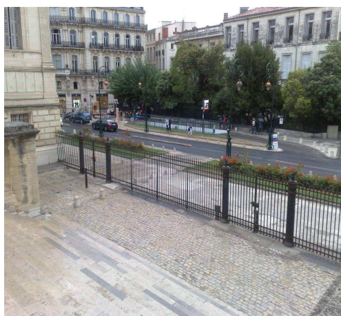
Exemple de clôture ceinturant le bâtiment
